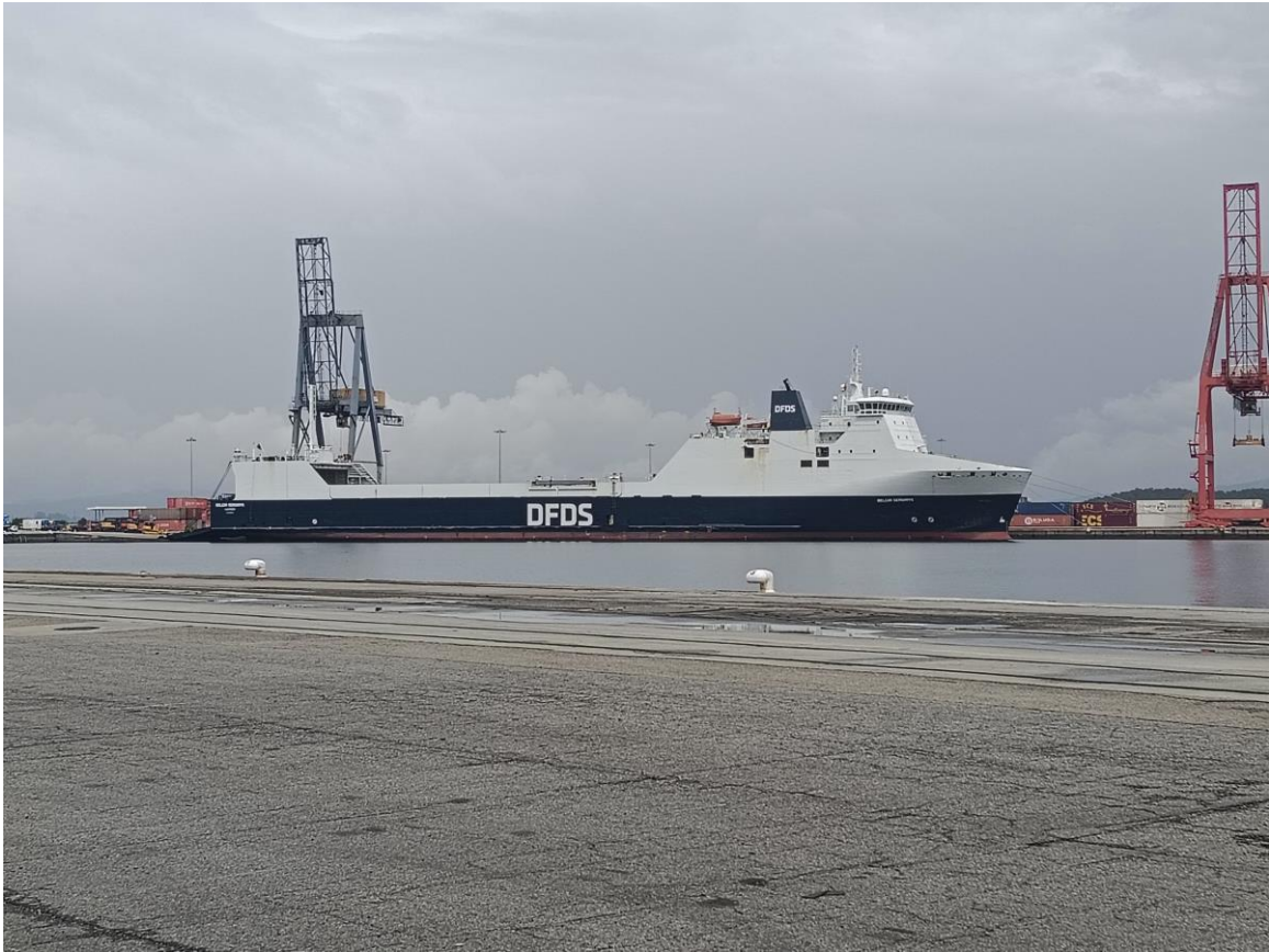
Buque descargando mercancía en la rampa Ro-Ro de Ferrazo
