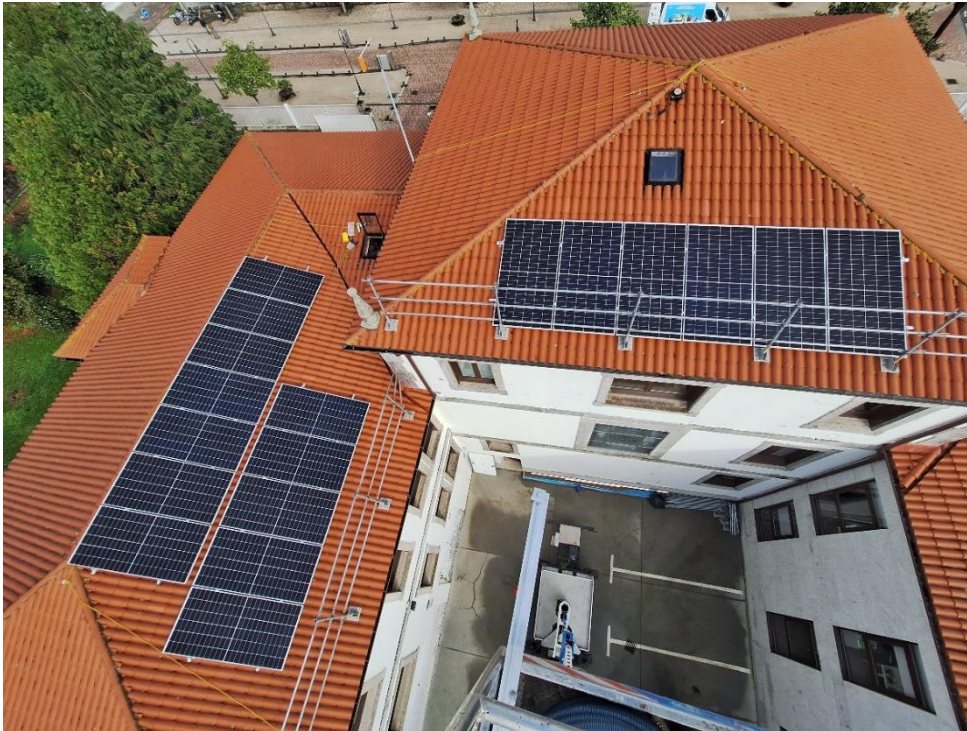
Instalación de placas solares en edificio de oficinas de la Autoridad Portuaria.
