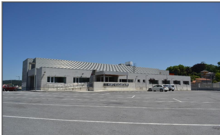
Punto de Inspección Fronteriza
